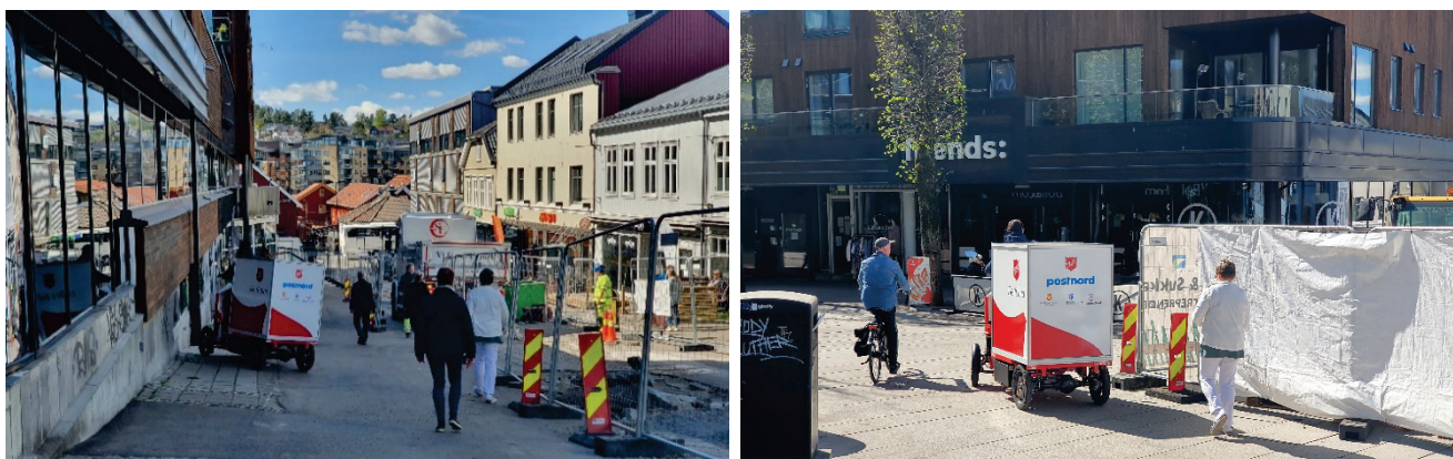
Figur 3-3: Bildene viser gateopprustning i Rådhusgaten som viser lastesykkelsens fleksibilitet (Bilder: Norconsult).
