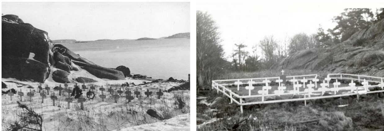
Figur 5. Fotografier av gravplassen. Bildet til venstre fra 40-tallet viser plassen sett mot sør, uten plankegjærde. Bildet til høyre viser plassen sett mot nord. Dette foto er trolig tatt på 50-tallet, og viser et steingjærde, plankegjærde og en større minnestein i bakkant. Fotograf ukjent for begge fotografier.
