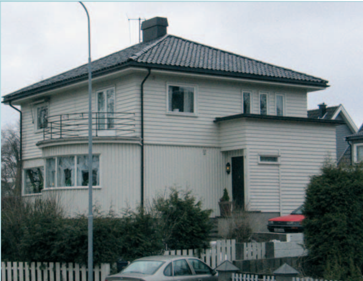
^ Typisk byggmester-funkis, Stenmalen i Tønsberg. Opprinnelig hadde huset funkisvinduer med to rammer Foto: Synnøve Tomter
