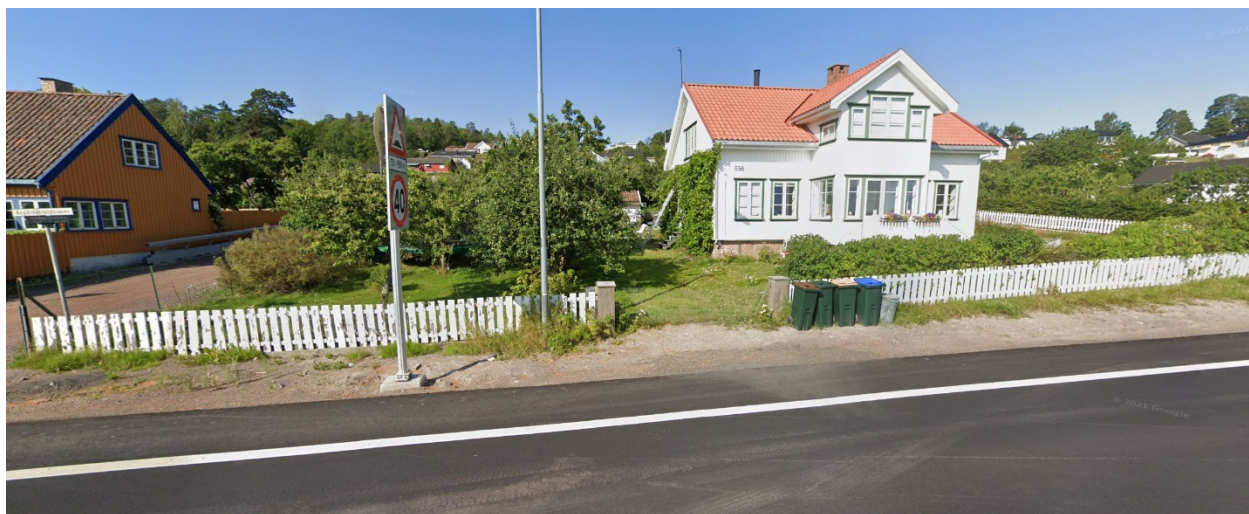
Figur 43. Åsgårdstrandsveien 556, med gangadkomst fra Åsgårdstrandsveien. Kjøreadkomst til eiendommen er fra Stangsåsveien, som ligger til venstre i bilde. Google maps - 2019.
