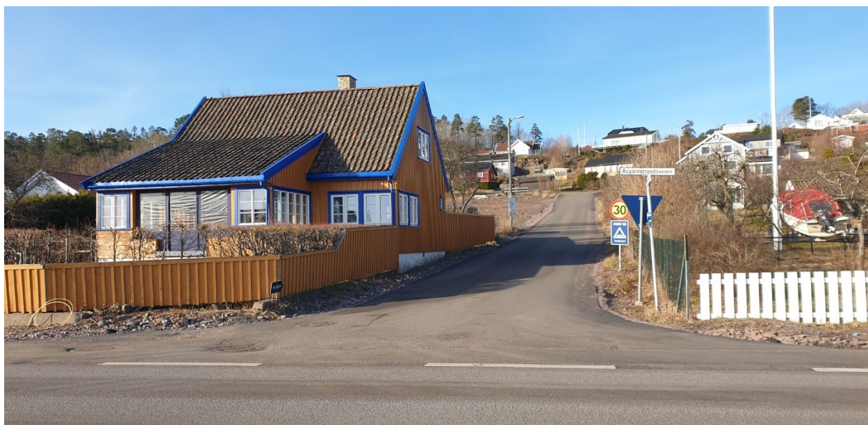
Figur 46. Fv.311 Åsgårdstrandsveien og kryss mot Stangsåsveien. Foto - VTFK.
