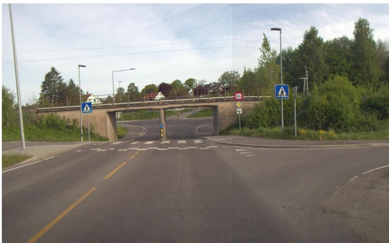
Høydebegrensninger er primært jernbanebruer, men også andre bruer samt Slottsfjelltunnelen i Tønsberg. Bildet viser jernbaneundergangen på fylkesvei 3052 Haslebakken i Sandefjord.
