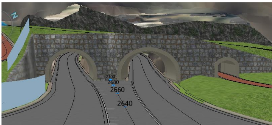
Figur 5-22: Portaler, Rambergtunnelen. GS-veitunnel til høyre.
