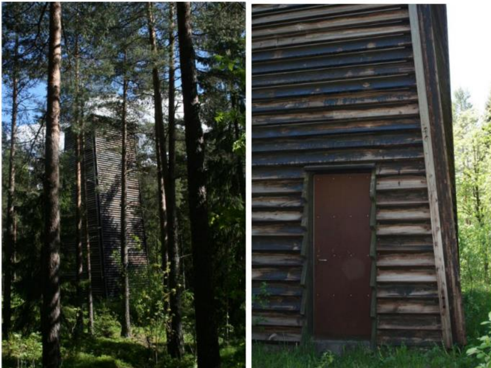
Figur 5-18 Eksempel på luftetårn, fra Bragernestunnelen i Drammen (Kilde: Statens vegvesen)
