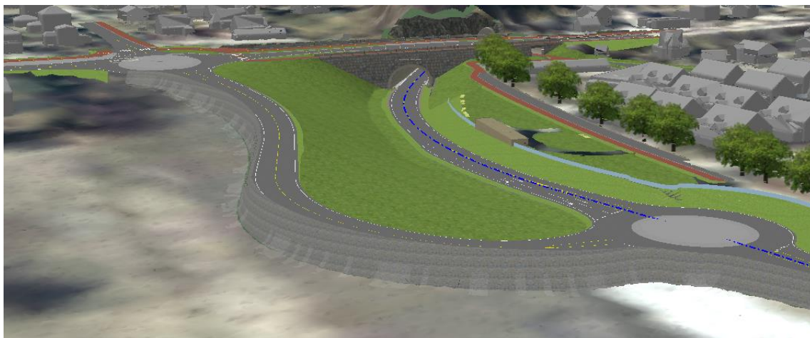
Figur 7-2 Tiltaket på Kolberg med den relativt høye støttemuren, sett fra sørøst. Støyvoll med lav skjerm til høyre for hovedtraséen.
