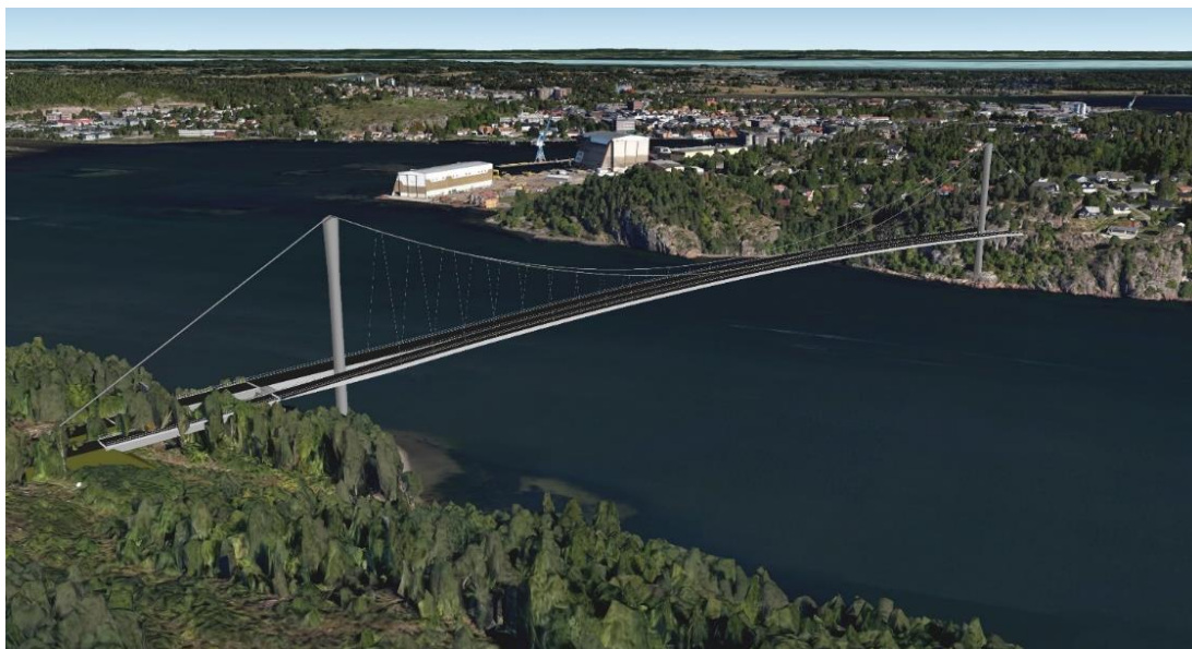
Figur 7-5 Færderbrua sett fra Vear.
