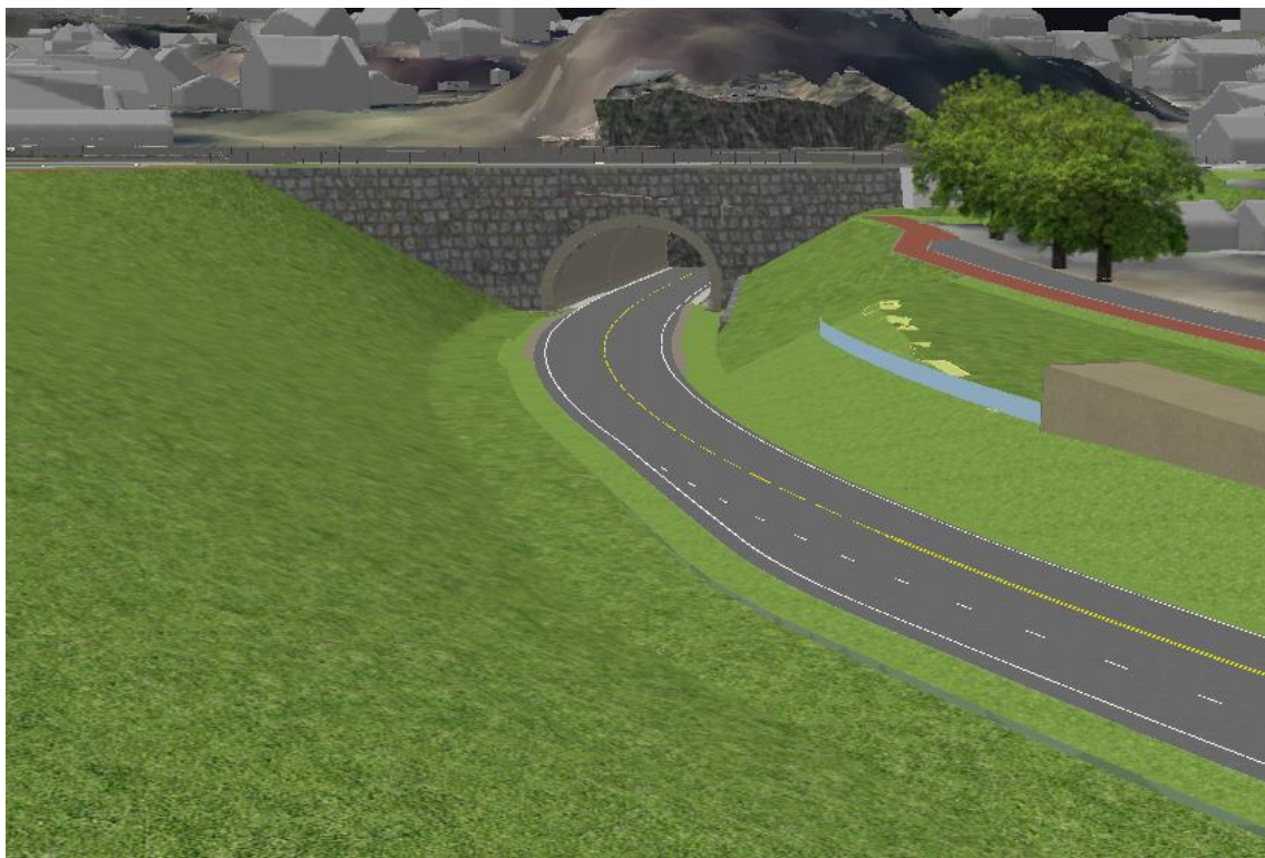
Figur 5-15: Portal, Teietunnelen fra Kolberg. Teknisk bygg i høyre bildekant
